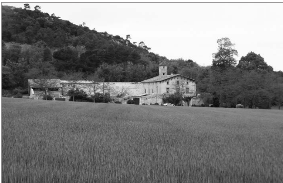
Fotografia de Montserrat Rumbau.
